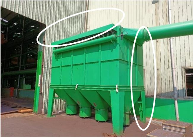
**現況說明：**新竹廠 D 棟南側集塵設備未加裝安全防護措施，人員上到頂部進行維修作業時有墜落風險。
