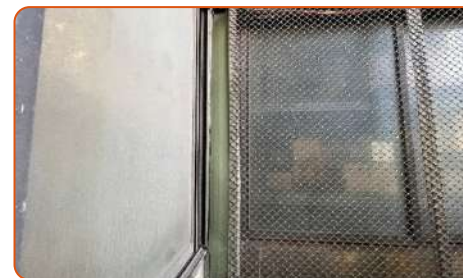
改善措施：先裁切一塊浪板，暫時封蓋
